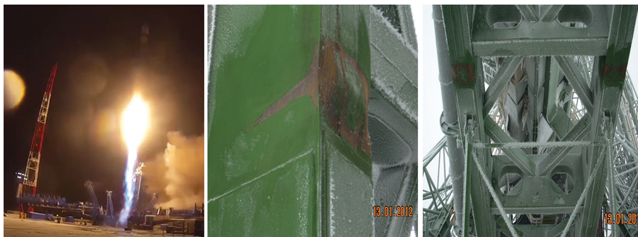
Рис. 2. Пример повреждения наземного технологического оборудования на стартовом комплексе из-за действия повышенной ветровой нагрузки
