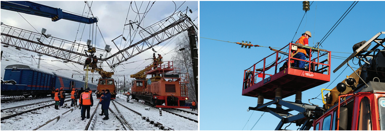
Рис. 2. Аварийно-восстановительные работы на ж/д станции «Выходная»
