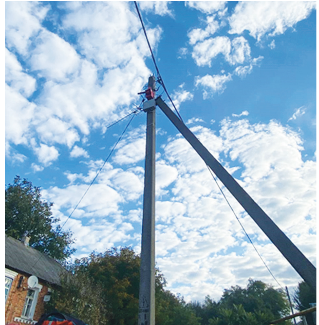
Рис. 2. Оконечное средство оповещения, управляемое по сети цифрового наземного эфирного телерадиовещания
