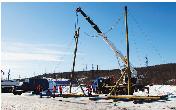
Рис. 3. Ремонтно-восстановительные работы опоры ЛЭП, проведенные ремонтно-восстановительными бригадами Мурманского филиала ПАО «Россети Северо-Запад»
