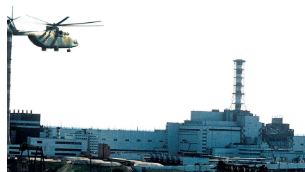
Рис. 1. Фото облета 4 реактора на вертолете с отбором проб воздуха на фильтры при ликвидации последствий аварии на ЧАЭС для контроля выбросов из реактора 3
