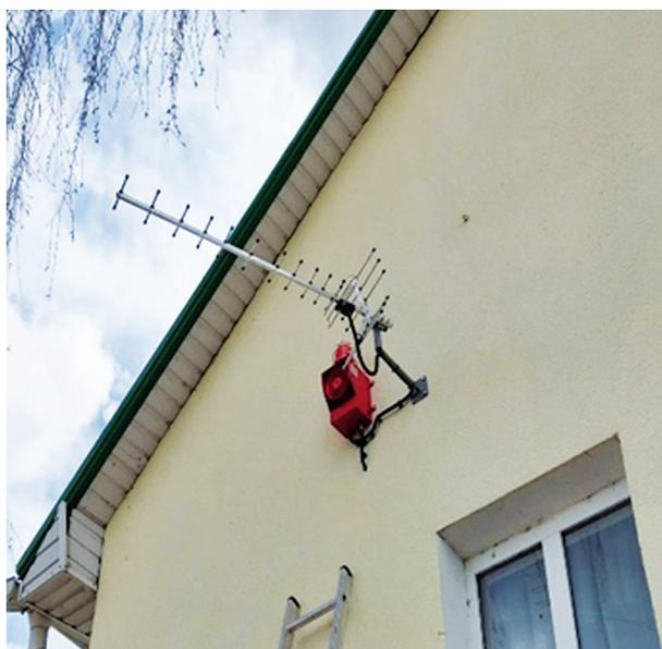
Рис. 1. ТСО «ОРАЛО», смонтированное на стене дома
