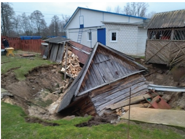
Рис. 1. Карстовый провал в поселке Вышков Брянской области с обрушенным домом, ноябрь 2021 г.
