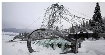
б) Порыв линии электропередачи
